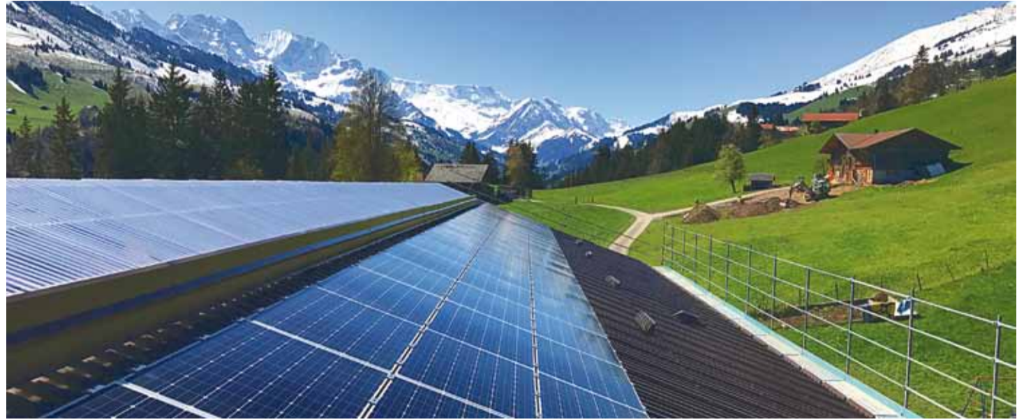
Solaranlage in Ried bei Fruttligen BE, Foto Peter Stutz
