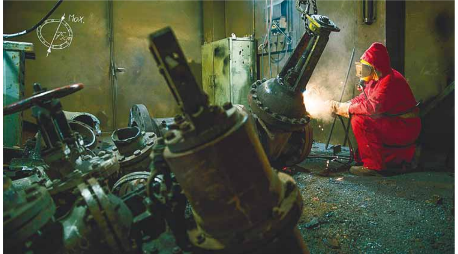
Rückbau im AKW Greifswald, Ex-DDR Foto Michael Jungblut
