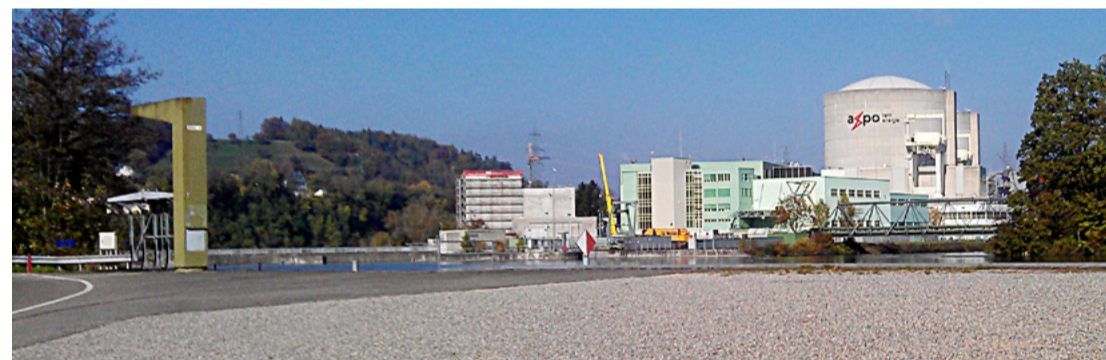
Gefährlich nah am Wasser gebaut: Das AKW Beznau an der Aare in Döttingen
